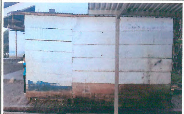
Foto 4: Mejoramiento de paredes, módulo 3
