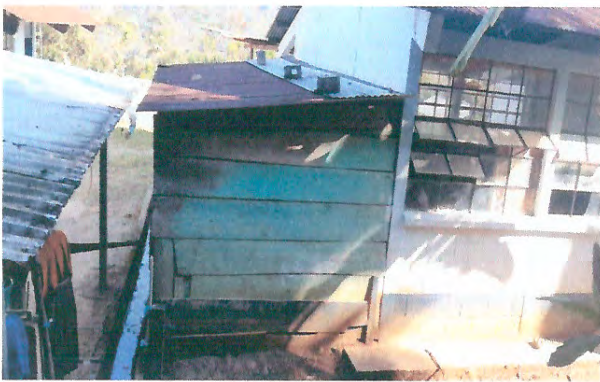
Foto 3: bodega módulo 3, mejoramiento de paredes
