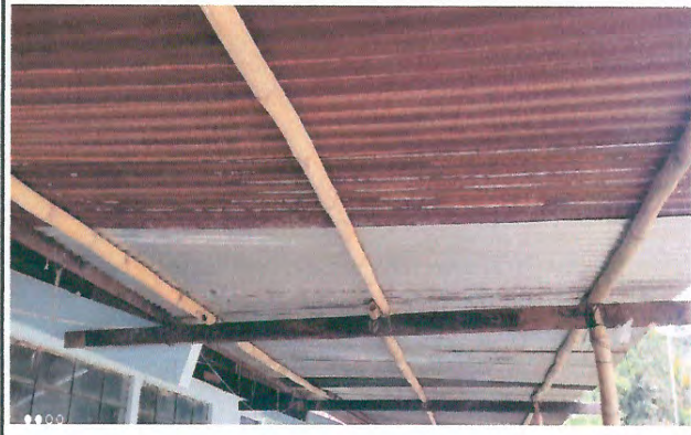
Foto 4: Módulo 2, estructura de techo
