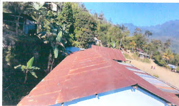
Foto 2: Módulo 4, cubierta de lámina
