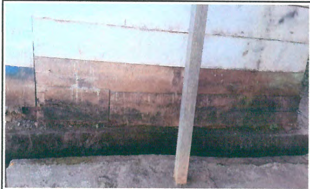
Foto 2: Módulo 3, mejoramiento de paredes
