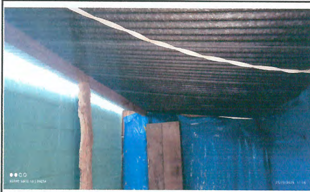
Foto 2: Módulo 3, estructura de techo
