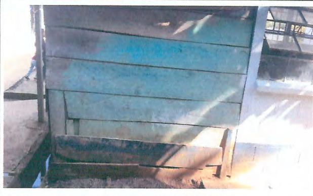
Foto 1: Módulo 3, mejoramiento de paredes
