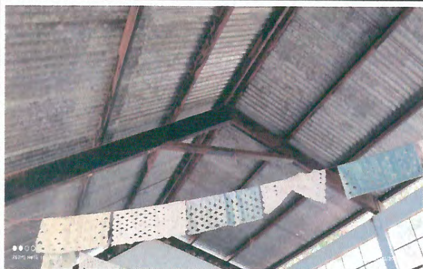
Foto 1: Módulo 4, estructura de techo
