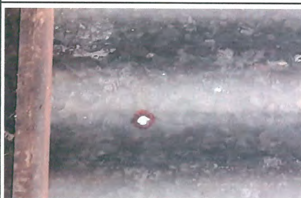
Foto 4: Módulo 3, cubierta de lámina
