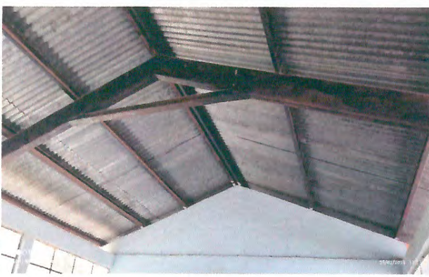
Foto 3: Módulo 2, estructura de techo
