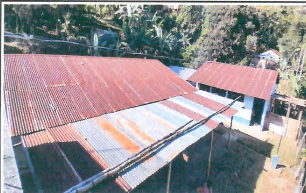
Foto 3: Módulo 2, cubierta de lámina
